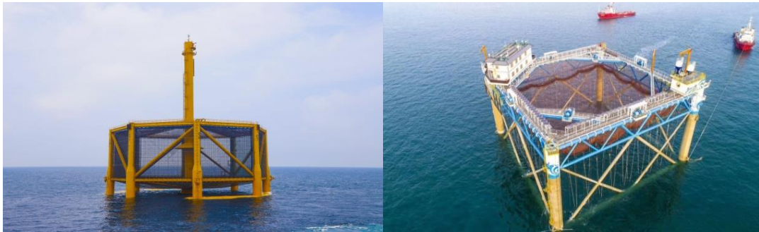
图 4.1.1.2 桁架类养殖设施
