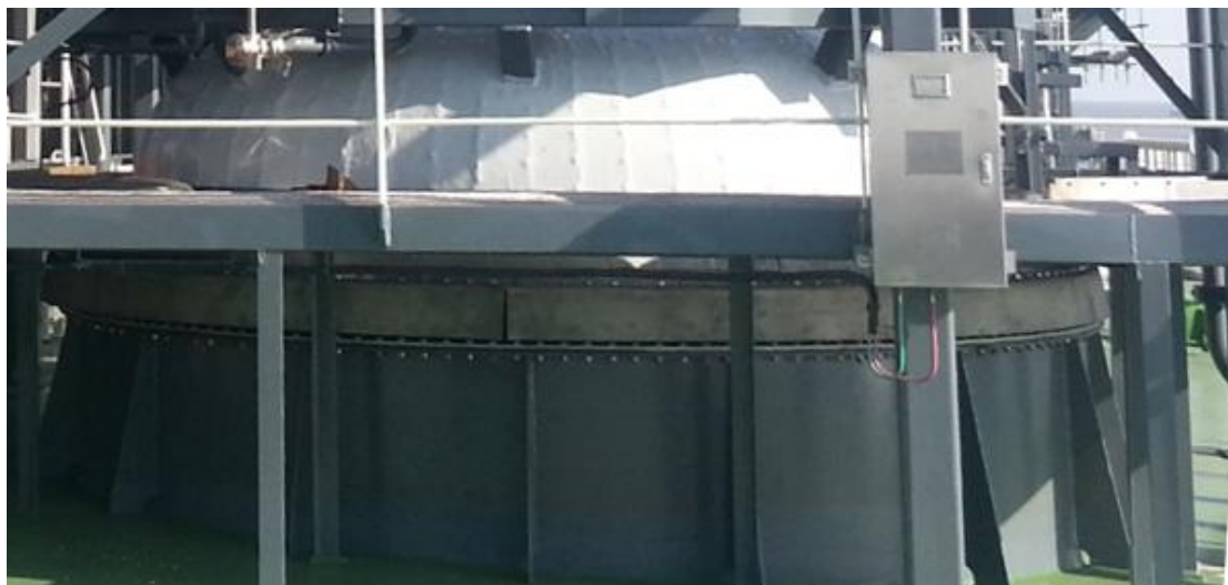
图 30- 气室密封膜圈的安装
