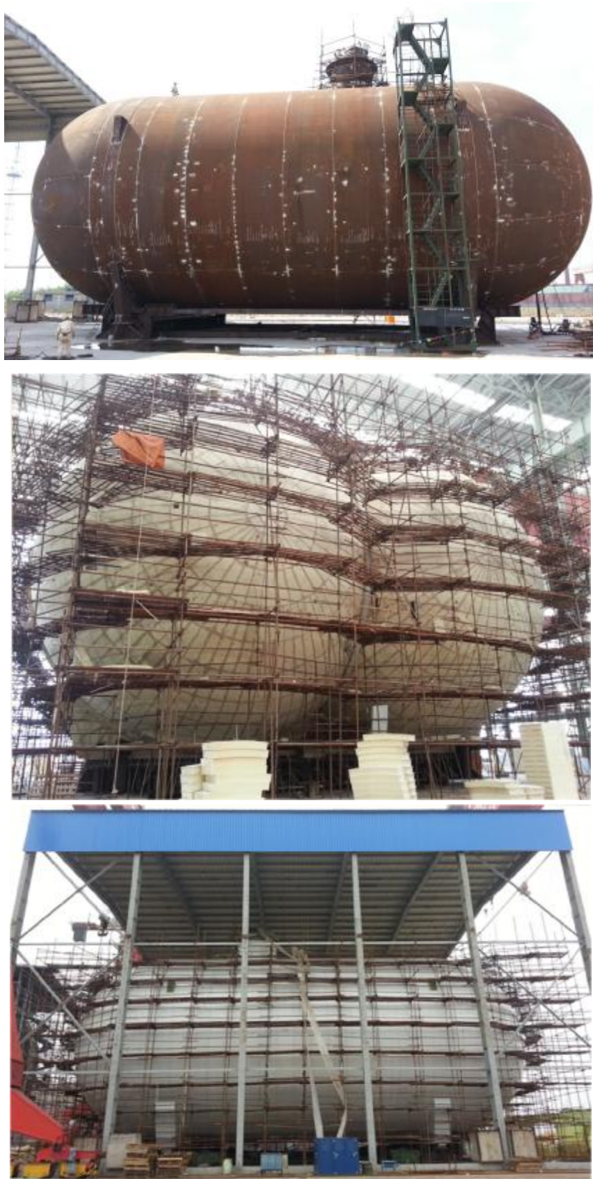
图 20- 罐体绝缘敷设
