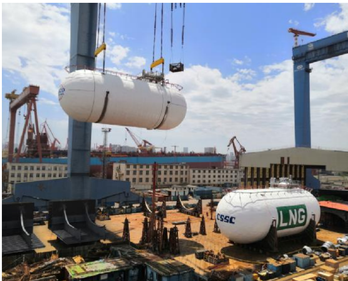
图 29- 全球首艘 LNG 双燃料 VLCC 燃料罐吊装现场
