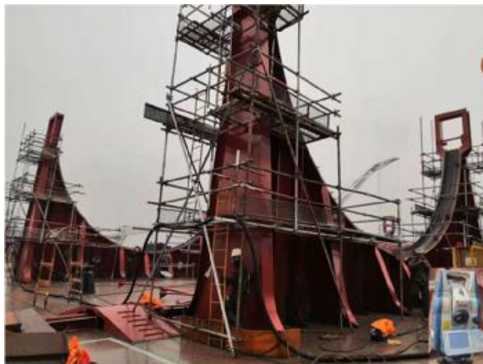
图 22- 罐体与船体鞍座线型匹配
