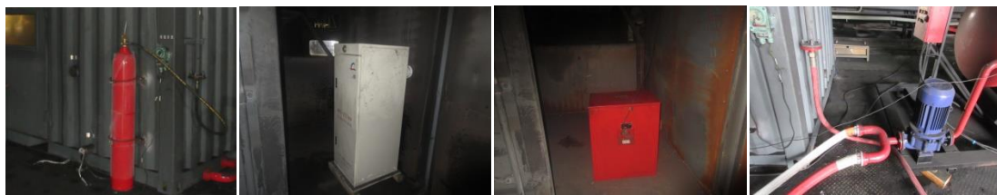
(a)二氧化碳灭火系统(管网式) (b)七氟丙烷灭火系统(柜式) (c)气溶胶灭火系统(柜式) (d)压力水雾灭火系统（水泵供水）
