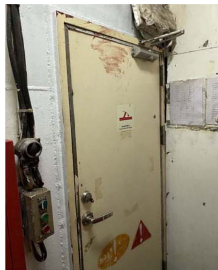
防火门框和墙壁间有缝隙 (焊接后)
