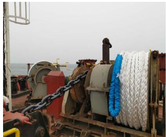
使用中的缆绳状况差 (已换新)
