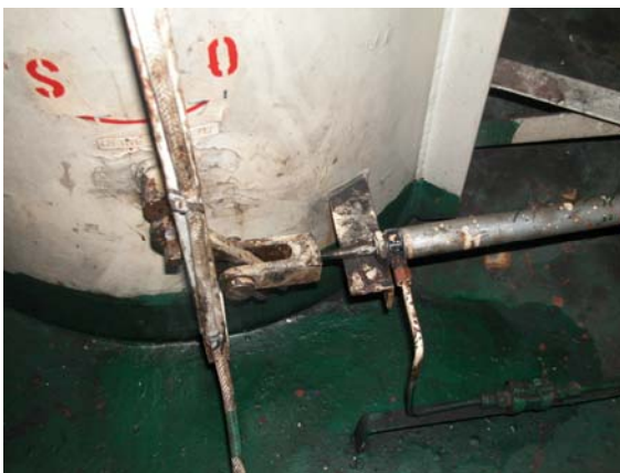
机舱防火风闸气动活塞的移动杆（U 型）
