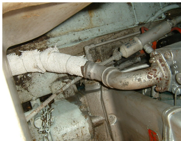
图示：救生艇艇机排气管
